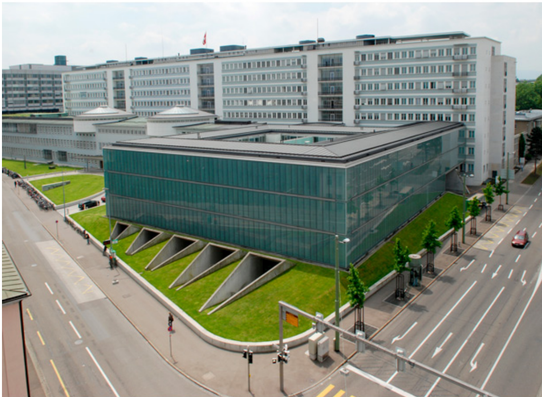
Die neue Frauenklinik ist heute im Klinikum I des Universitätsspitals untergebracht. Im Vordergrund der Behandlungsbau mit der Poliklinik der Frauenklinik (Erdgeschoss), OP-West (1. Etage) und Gebärdabteilung (2. Etage); im Hintergrund das Bettenhaus.
