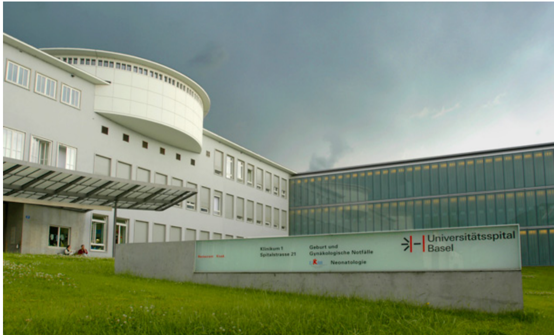
Eingang zur neuen Frauenklinik an der Spitalstrasse.
